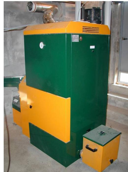
Caldaia per riscaldamento aziendale, potenza 80 kW.
