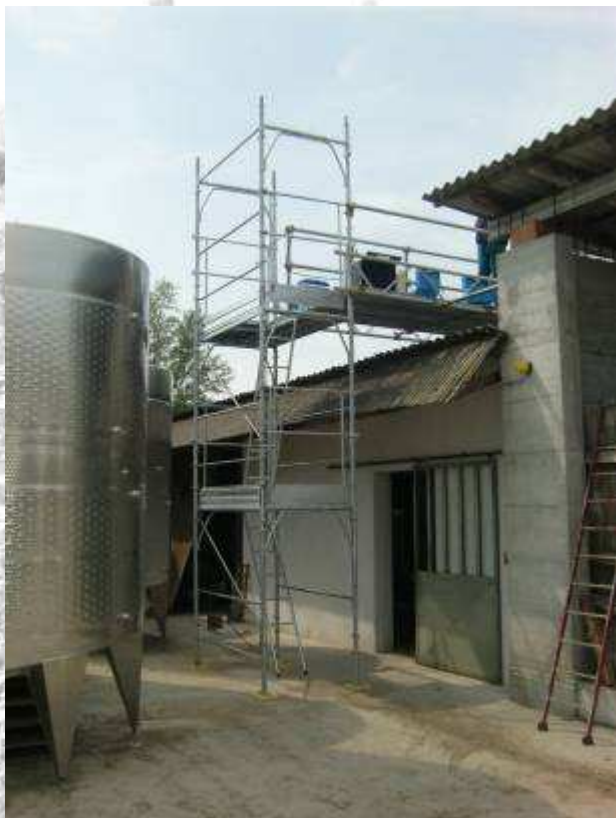
Ponteggio sopra locale caldaia comprensivo di piattaforma di lavoro
