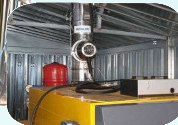
Filtro elettrostatico
